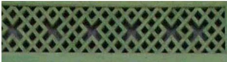
<도판-34, 35> 「昌德宮 大造殿」卍字箭, 卍字箭 交窓, 보물816호, 1920년 중건
