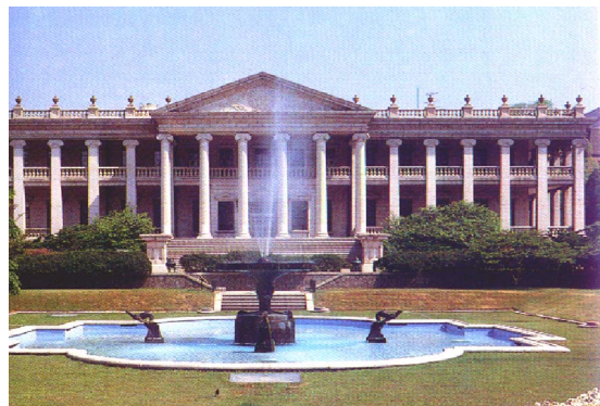
<도판-62> 「德壽宮 石造殿」 전경, 1909년 창건
